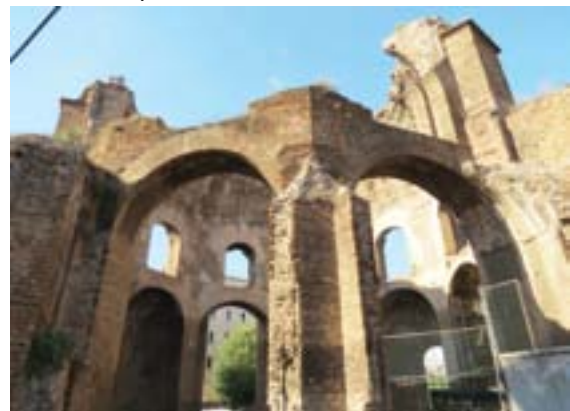
Lato via Giolitti prima del restauro
